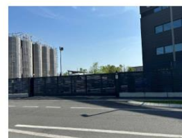
INGRESSO CARRABILE - CIVICO 2C apertura automatizzata scorrevole 9,00 m
