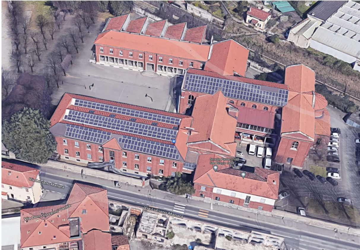
Fig. 12 – complesso scolastico di fronte all'area di interesse, sul retro si vede la ferrovia
